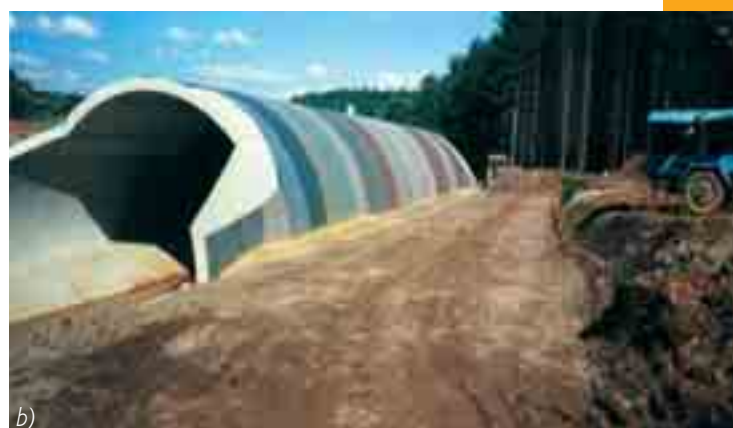
Obr. 1 Tenkostěnný obloukový přesypávaný most TOM2, a) analýza konstrukce, b) sestava konstrukce před zasypáním
