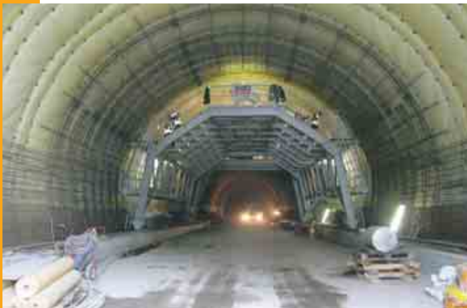
Obr. 5 Posuvný vozík pro instalaci výztuže Fig. 5 Mobile truck for the reinforcement installation
