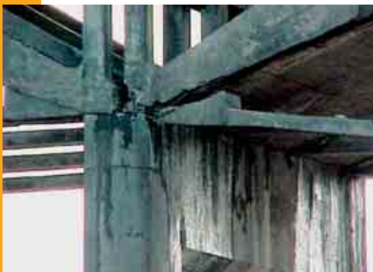
Obr. 3 Pohled na porušený tříkloubový obloukový styčník
