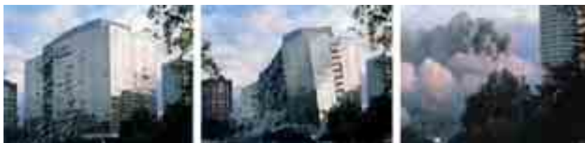
Obr. 2 Odstřel – Connecticut, USA, 2000 Fig. 2 Blasting – Connecticut, USA, 2000
