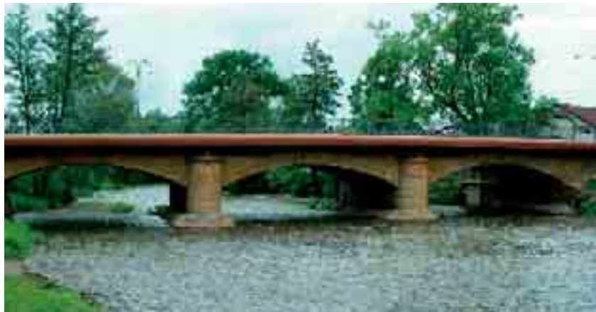
Obr. 1 Most ve Slatiňanech ošetřený hydrofobním nátěrem
