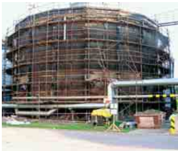
Obr. 1 Vyhnívací nádrž č. 7 po sejmutí vnějšího pláště
