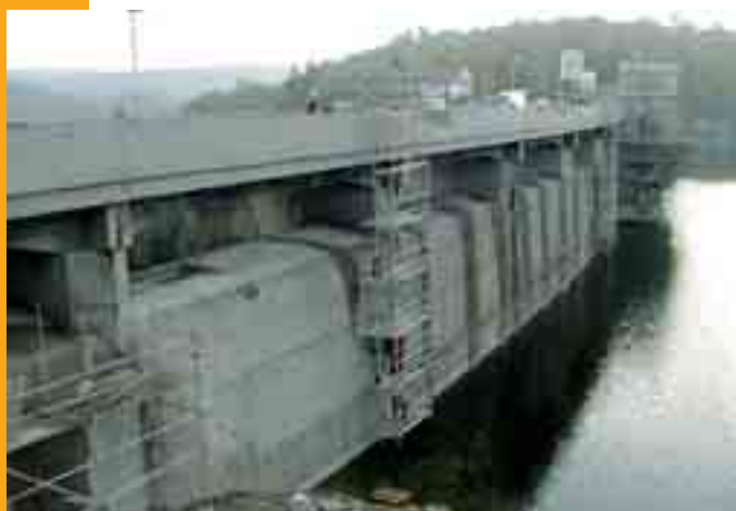
Obr. 5 Zavěšené lešení na návodním líci Fig. 5 Suspension scaffolding on the upstream face
