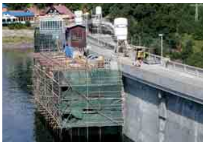
Obr. 6 Blok nátoků do elektrárny
