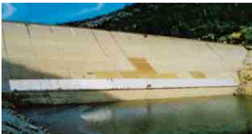
Obr. 3 Přehrada Olivenhain (Kalifornie), návodní plášťové těsnění – fólie PVC
