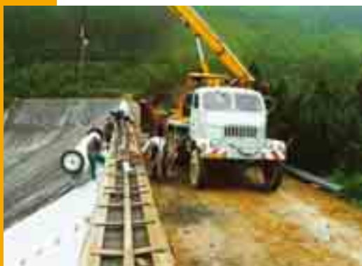
Obr. 3 Přehrada Olivenhain (Kalifornie), návodní plášťové těsnění – fólie PVC
