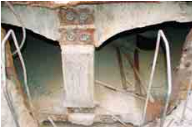
Obr. 5 Strop A – kotvy předpínací výztuže
