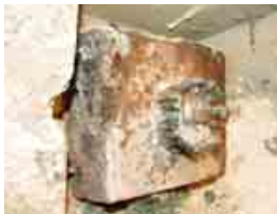
Obr. 5 Strop A – kotvy předpínací výztuže
