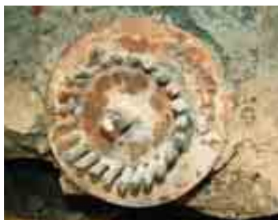
Obr. 6 Strop B – kotvy předpínací výztuže
