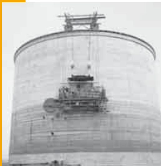
Obr. 6 Ovíjecí vozík na horní části nádrže Fig. 6 The winding device on the upper part of the tank
