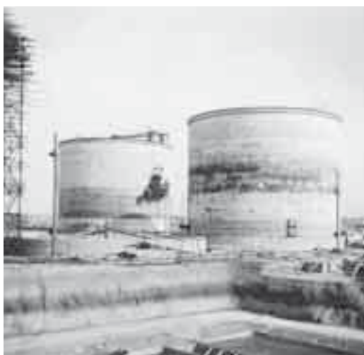
Obr. 8 Nádrže během předpínání. Na bližší jsou patrné kotevní nálitky kabelů
