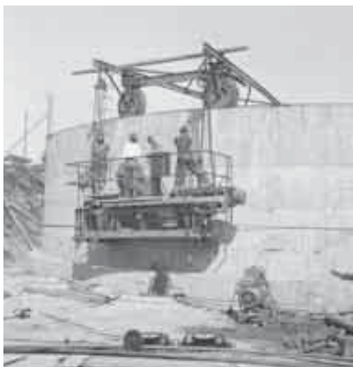
Obr. 6 Ovíjecí vozík na horní části nádrže Fig. 6 The winding device on the upper part of the tank
