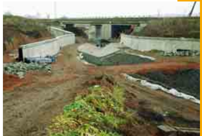
Obr. 4 Stávající most pod silnicí III/25364 Fig. 4 Existing bridge under Road III/25364
