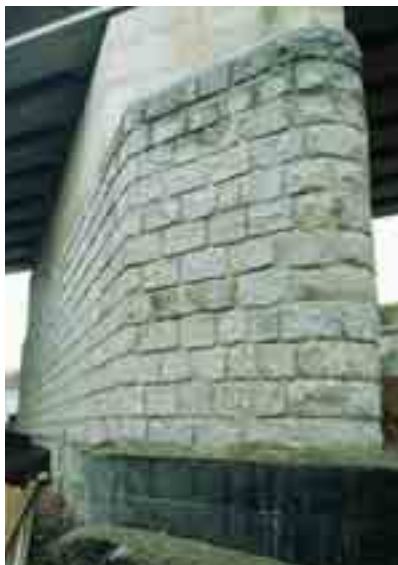
Obr. 5 Obklad středního pilíře stávajícího mostu
