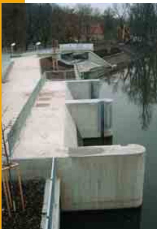
Obr. 7 Vtok do čerpací stanice a odlehčovací objekt
