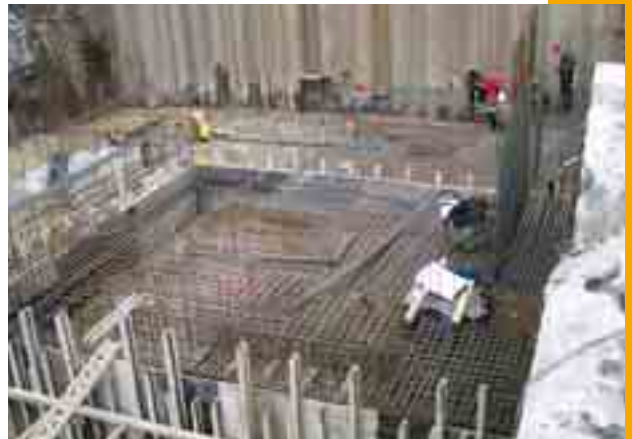
Obr. 8 Betonáž základové desky uzávěru přístavu Fig. 8 Concreting of basic slab at the gate of port
