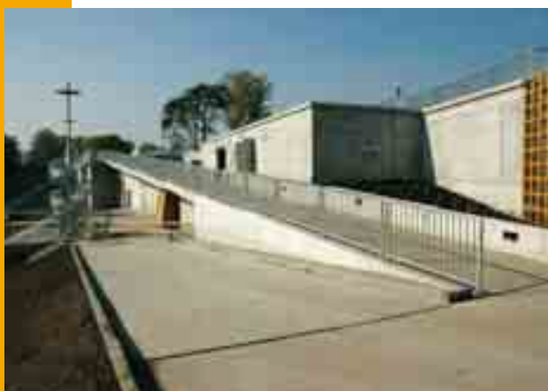
Obr. 11 Celkový pohled na strojovnu čerpací stanice a cyklostezku
