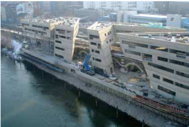
Obr. 5 Historické oblouky mostní konstrukce městské dráhy včleněné do moderní budovy
