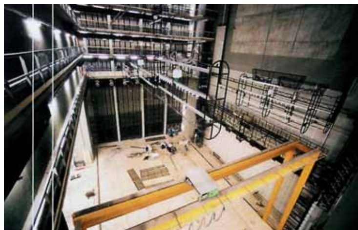
Obr. 3 Montáž technologií na betonové stěny nového jeviště [1]
