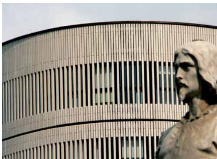
Obr. 10 Detail mramorové fasády na železobetonové konstrukci
