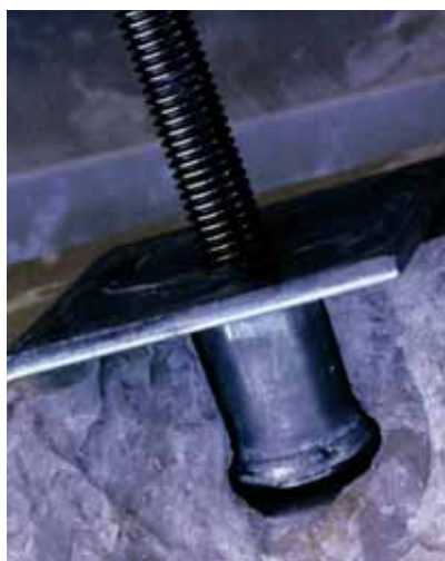
Obr. 8 Detail kotevního prvku [1]
