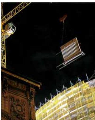
Obr. 6 Montáž fasády [1]
