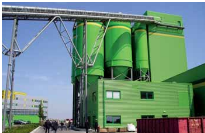
Obr. 2 Zásobníky a mísící jádro s kapacitou 90 m 3 betonu/hod.
