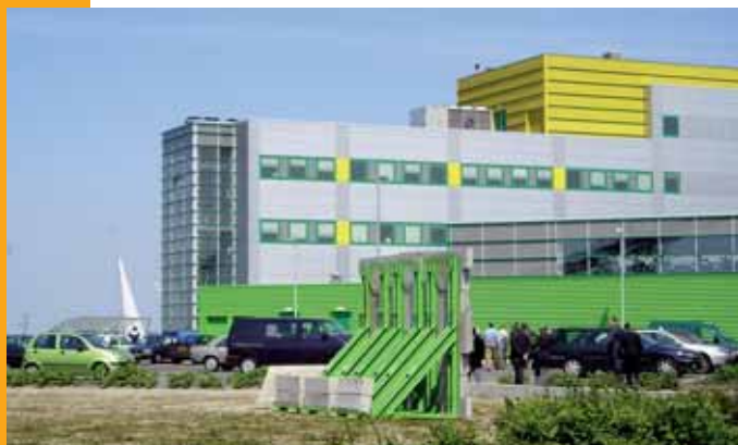
Obr. 1 Administrativní budova, odkud je řízený provoz celého areálu
