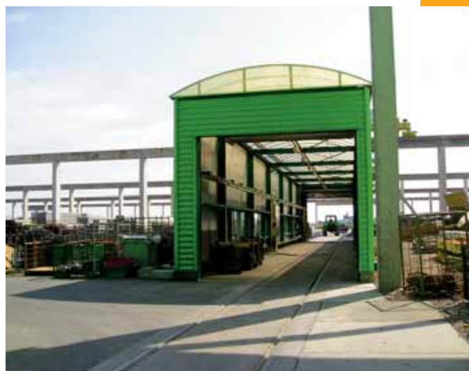
Obr. 6 Tunel s výstupní kontrolou
