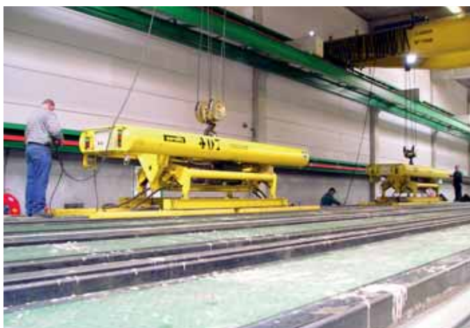
Obr. 5 Manipulace s pilotami se provádí jeřábem s podtlakovým přísavným zařízením
