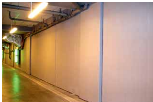
Obr. 10 Interiér parkingu s pohledem na suterénní stěnu
