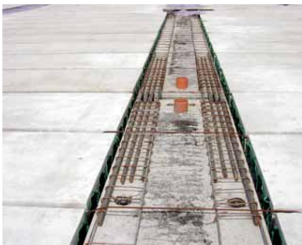
Obr. 7 Detail výztuže průvlaku nad podporou před uložením nadbetonávky Fig. 7 Detail of reinforcement of a girder above the support prior to placing the topping
