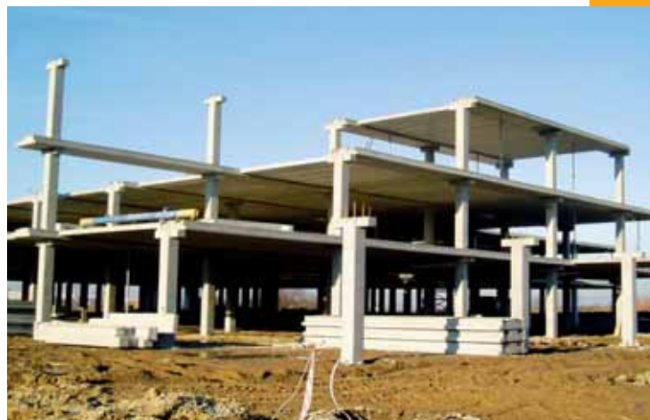
Obr. 16 Prefabrikovaná konstrukce v montážním stádiu
