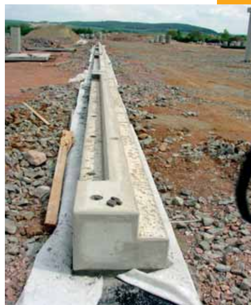
Obr. 8 Úložné prahy pro obvodové suterénní stěny Fig. 8 Bearing blocks for peripheral ground floor walls
