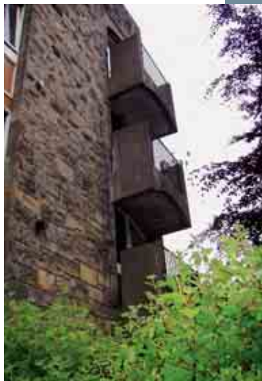
Obr. 15 Monolitické betonové balkony na historickém kamenném mostě
