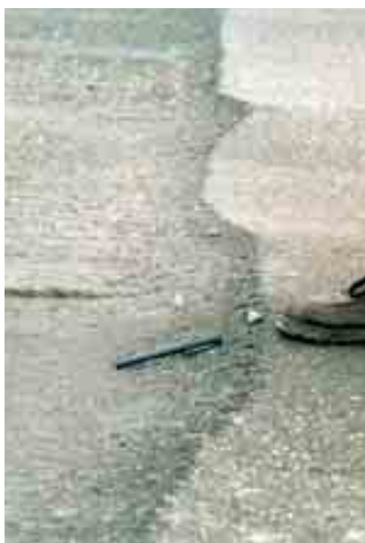
Obr. 2 Vyjeté koleje / vyfrézovaný podklad Fig. 2 Ruts left by trucks / mill out bottom
