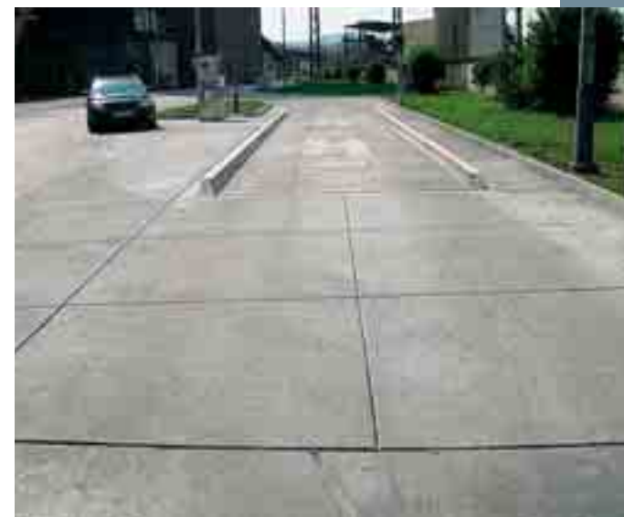
Obr. 7 Dokončená oprava asfaltového povrchu, cementárna Wetzlar, SRN, 2004 Fig. 7 Finished replacement of asphalt cover, cement factory in Wetzlar, Germany, 2004
