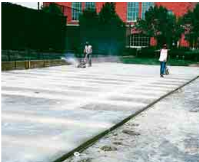
Obr. 5 Použití UTW, Urbana, USA 1998 – prořezávání spár
