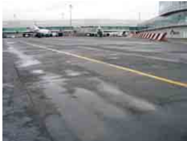
Obr. 4 CB vozovka opravená tenkou živčnou vrstvou, jsou patrné vyjeté koleje od podvozků letadel
