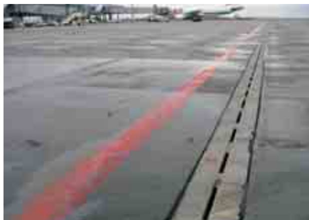
Obr. 2 Plocha Sever pro odbavování největších letadel Fig. 2 Apron North for handling of the biggest aircrafts
