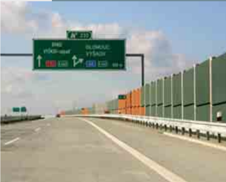
Dálnice D1, 231. km, směr Praha Highway D1, 231 st km, direction to Prague
