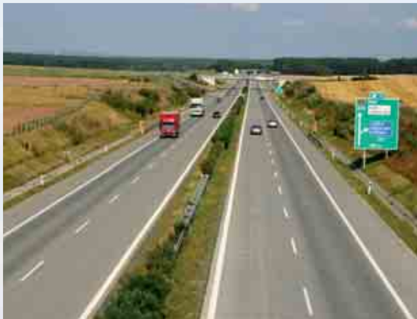
Dálnice D5, 94. km, směr Praha Highway D5, 94 th km, direction to Prague
