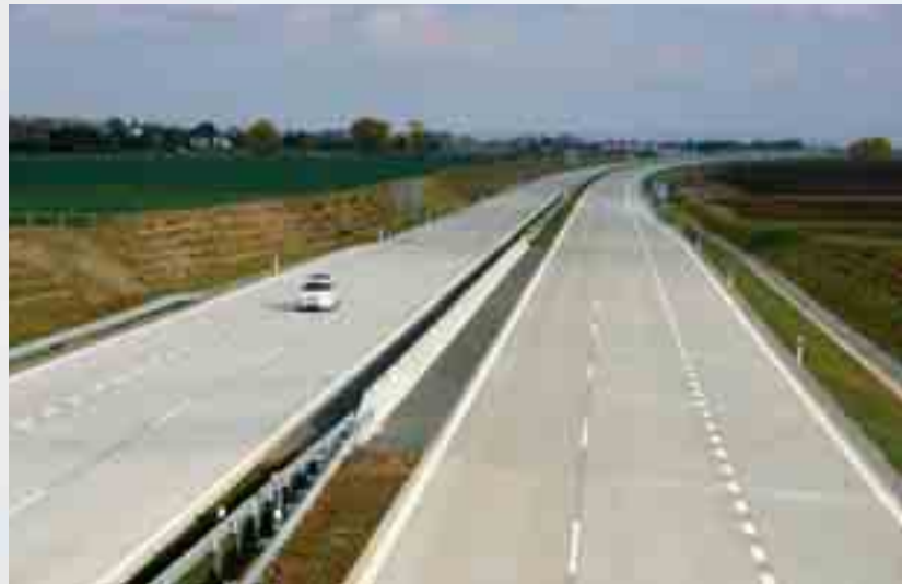
Dálnice D1, 244. km, směr Ostrava Highway D1, 244 th km, direction to Ostrava
