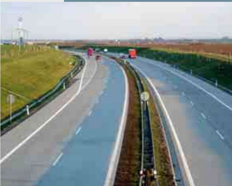
Rychlostní silnice R35 u Olomouce Highway R35 near Olomouc
