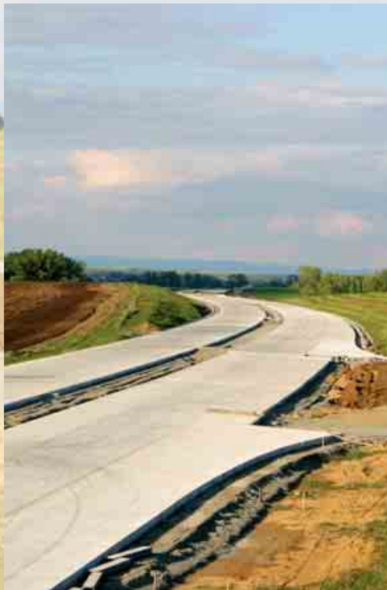
Výstavba dálnice D1, 236. km Building of highway D1, 236 th km
