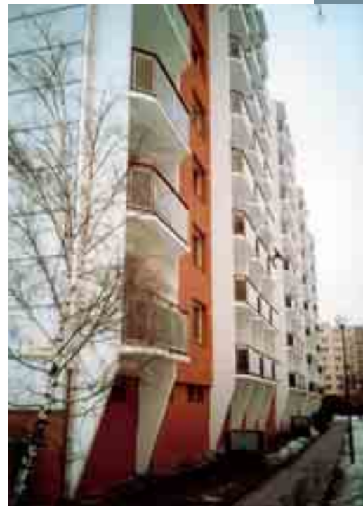
Obr. 1 Lodžie osmipodlažního panelového domu Fig. 1 Loggia of an eight-storey prefabricated panel building
