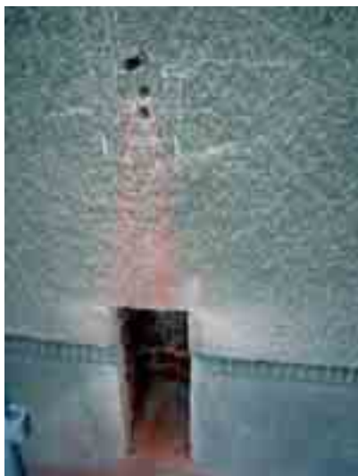
Obr. 9 Vyřezaná drážka v cihelném zdivu pro uložení krátké konzoly
