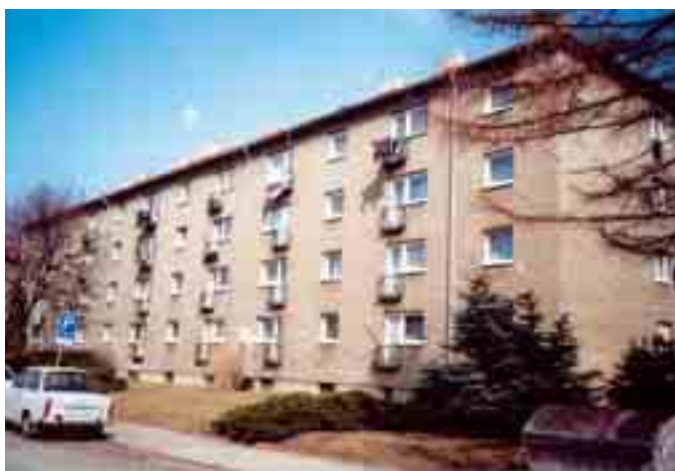
Obr. 7 Zděný dům – původní stav Fig. 7 Masonry house – original condition
