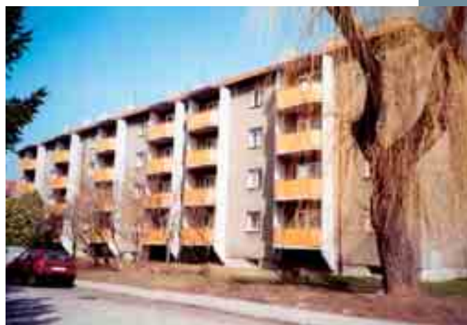
Obr. 8 Zděný dům, smontované lodžie Fig. 8 Masonry house, assembled loggias
