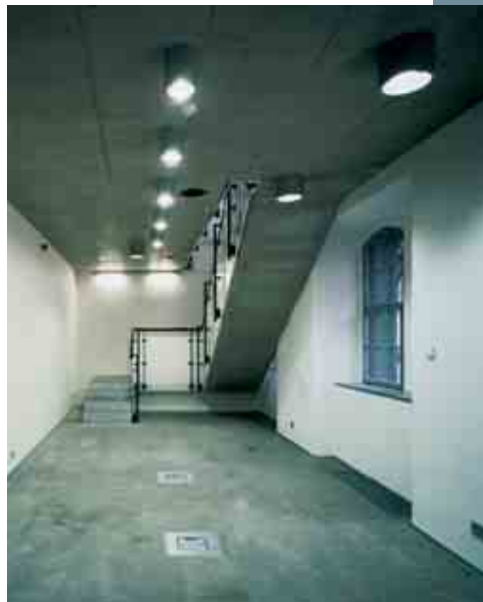
Obr. 5 Přízemí objektu Machine House, strop a schodiště z pohledového betonu
