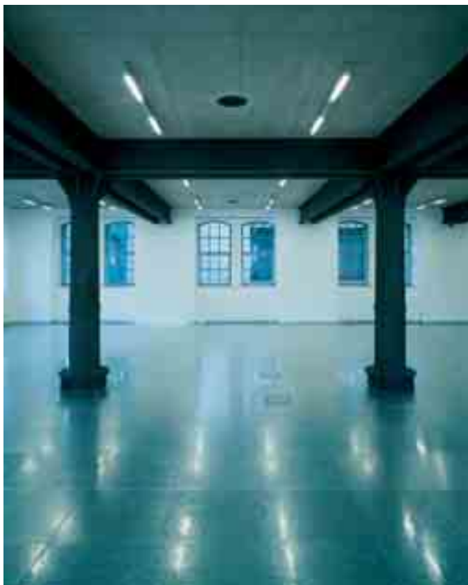
Obr. 4 Stropy z pohledového betonu a litinové sloupy
