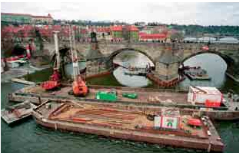
Obr. 11 Staveniště Fig. 11 Construction site
