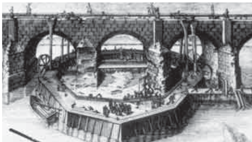
Obr. 1 Foto mědirytiny vyhotovené po povodni r. 1784 znázorňující rekonstrukci pilířů č. 5, 6 a 8; archiv Památník písemnictví na Strahově Fig. 1 A photo of a copper engraving which was made after a flood in 1784. The engraving shows a reconstruction of piers no. 5, 6 and 8; Archive Památník písemnictví at Strahov
