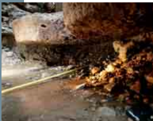
Obr. 10 Detail prostoru pod mlýnskými kameny u pilíře č. 9 Fig. 10 A detail of a space under the millstones by the pier no. 9
