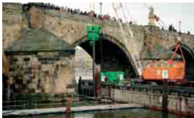
Obr. 3 Instalování štětovnic Larsen III Fig. 3 An erection of sheet piles Larsen III
