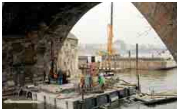
Obr. 4 Provádění tryskové injektáže pod mostním obloukem Fig. 4 Carrying out of jet-grouting under an arch of bridge
