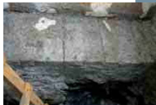
Obr. 6 Základový ústupek u pilíře č. 8
