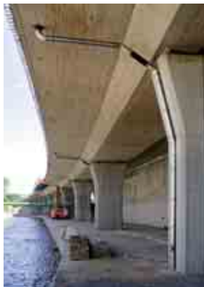
Obr. 6 Spodní stavba mostu podél přeložky Nisy, detaily odvodnění
