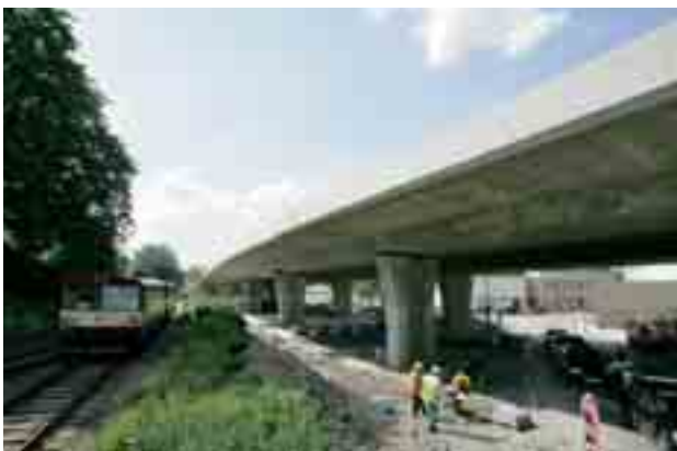
Obr. 4 Most přes Poštovní náměstí Fig. 4 The bridge over Poštovní square
