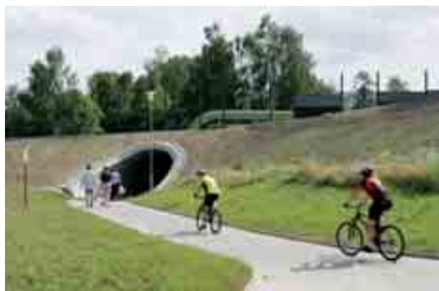
Obr. 10 Podchod pro pěší v MÚK Zelené údolí Fig. 10 The pedestrian subway in the grade-separated crossing Green valley (Zelené údolí)
