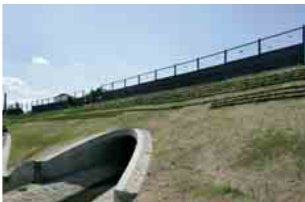
Obr. 8 Most přes Vesecký potok Fig. 8 The bridge over Vesecký brook
