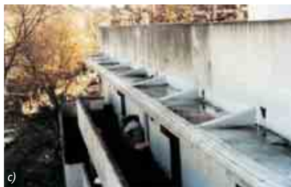
Obr. 4 Vnější konstrukce zchátralá po „dekádách zapomnění“, rok 2001, a) zadní trakt a fasáda budovy, b) zkorodovaná výztuž a odprýskávající beton, c) parapet střešní terasy s markýzou nad balkonem v nižším podlaží
