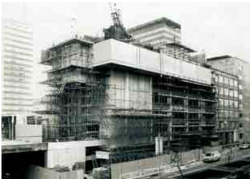
Obr. 5 Lešení pod konzolovou schodišťovou věží
