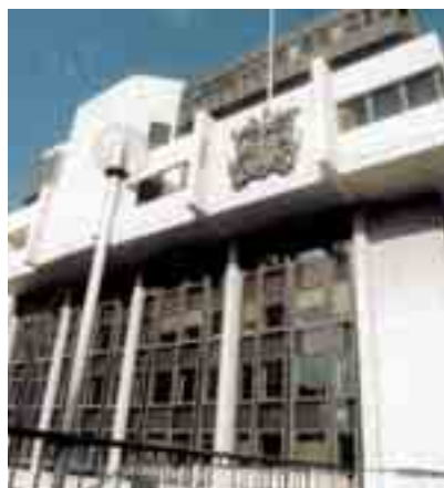
Obr. 7 Průčelí budovy směrem k St. Alphage Gardens
