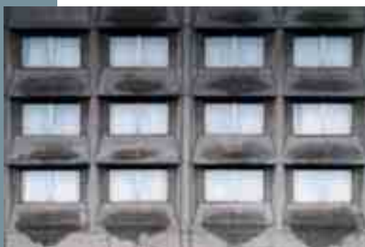
Obr. 3a, b Zmoknutím betonový povrch ztmavne
