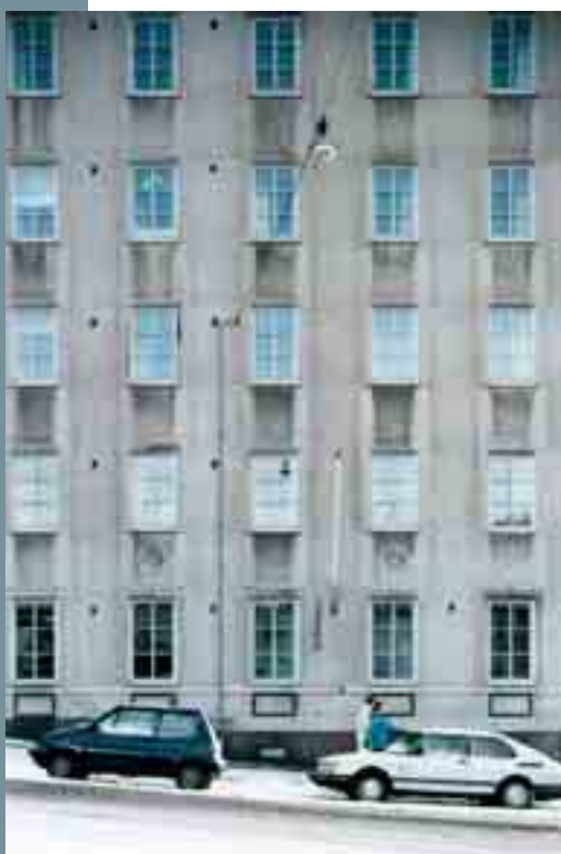
Obr. 4 Povrch průčelí se stopami prachu a deště
