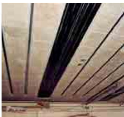
Obr. 5 Železobetonová deska zesílená použitím FRP lamel
