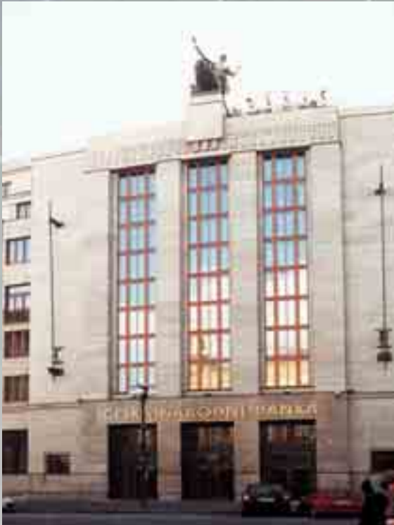
Česká národní banka (rekonstrukce nosného skeletu) / Czech National Bank
