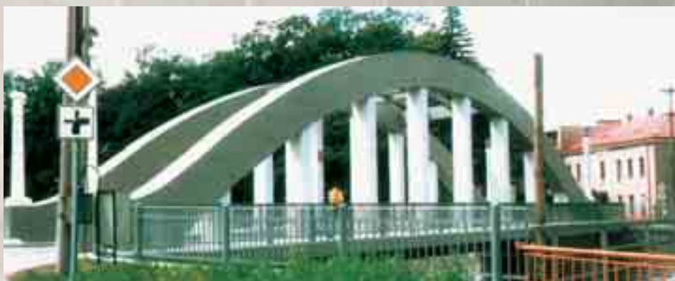
Generální rekonstrukce mostu v Doudlebech nad Orlicí – sanace mostních oblouků a masivní objemová injektáž Capital reconstruction of bridge in Doudleby nad Orlicí – maintenance of bridge arches and massive volume injection
