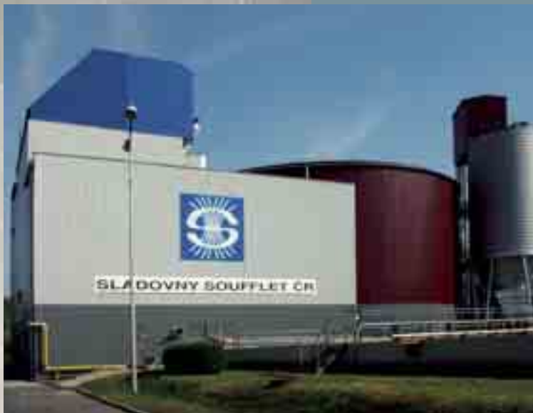
Sladovna Nymburk – výstavba nového dvoulískového hvozdu – tepelně izolační systém / Malt plant in Nymburk – construction of new double-kiln – thermal-insulating system
