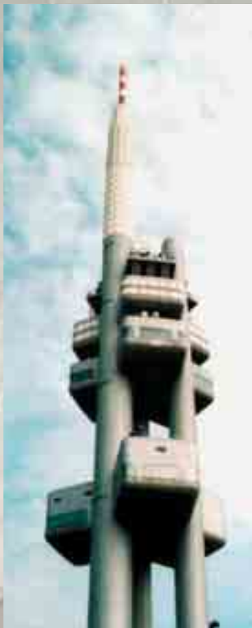
Rekonstrukce Žižkovské věže v Praze 3 – sanace terasy v 11. patře Reconstruction of Žižkov Tower in Prague 3 – maintenance of terrace on the 11th floor
