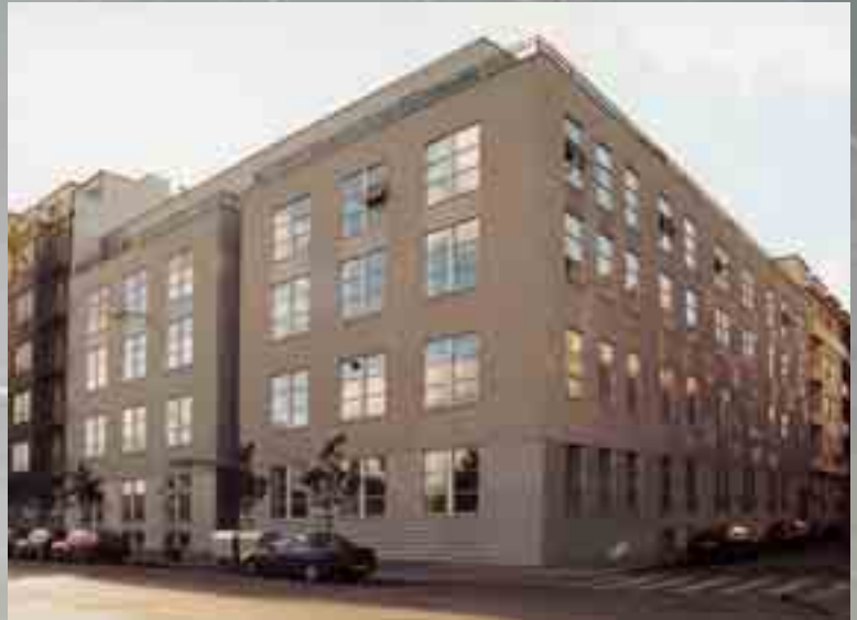
Administrativní objekt Jankovcova ul., Praha 7 – sanace a hydroizolace suterénních prostor Administrative building in Prague 7, Jankovcova street – maintenance and hydroinsulation of the basement space
