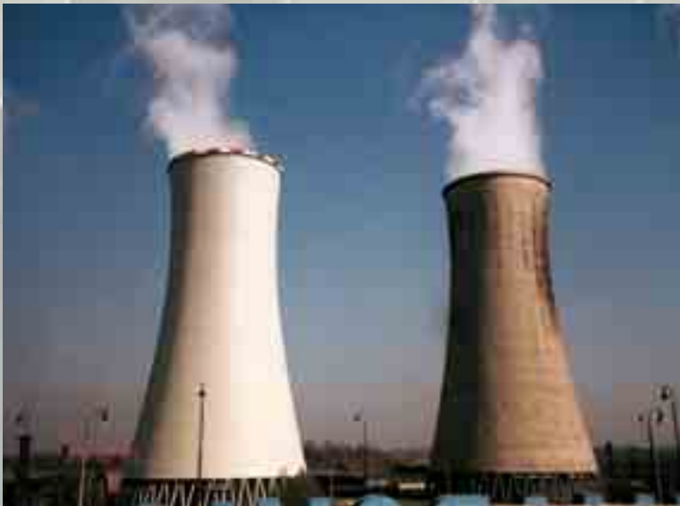
Elektrárna Dětmarovice – sanace pláště chladicí věže Power plant Dětmarovice – maintenance of cooling tower sheath
