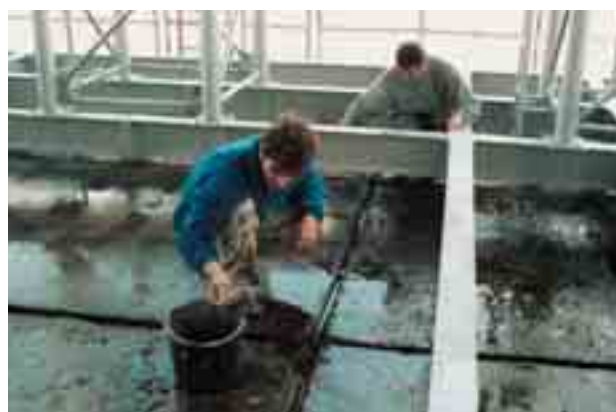
Obr. 2 Sanace terasy v 11. patře Žižkovské věže v Praze 3
