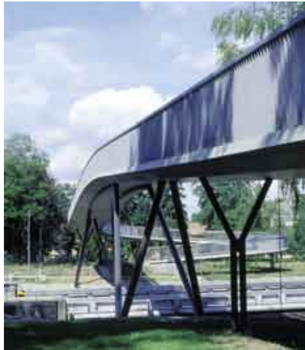
Obr. 2 Vítězná stavba 3. ročníku v kategorii mosty – Lávka pro pěší u zdymadla v Poděbradech
