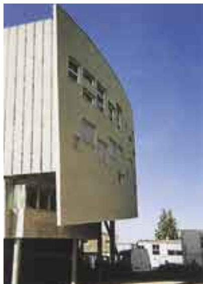
Obr. 2 Interní střední škola v Nevers, stěny výšky 8,3 a 6,4 m, délky 23 m a tloušťky 100 mm, 870 m 3 self-leveling RMC, 2002
