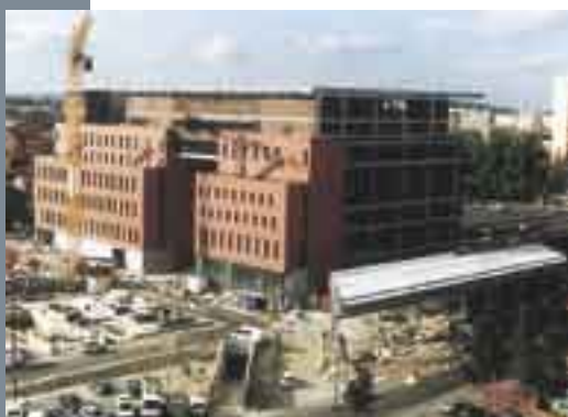
Obr. 5 Multimediální knihovna v Toulouse, stěny výšky 10,4 m, délky 13,1 m a tloušťky 250 mm, 1 200 m 3 SCC, 2002
