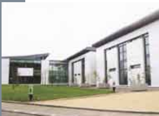
Obr. 1 Centrum regionální správy v Luisant, 320 m 3 SCC, 2001
