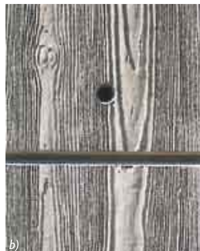
Obr. 3 Rozšíření školního komplexu Paula Langevina v Bagnolet, stěny výšky 3,5 m, délky 6 m a tloušťky 200 mm, 200 m 3 self-leveling RMC, b) detail povrchu s otiskem dřevěného bednění, 2001
