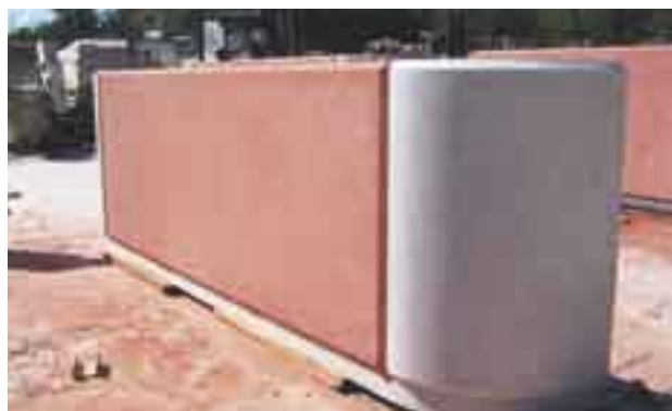
Obr. 8 Prefabrikované prvky mostních pilířů z červeného betonu s opískovaným povrchem délky 3,5 m, výšky 1,04 m a tloušťky 120 mm
