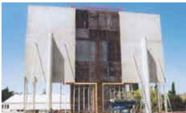
Obr. 7 Sportovní centrum v Cholet, betonové stěny 10 m vysoké na 4 m vysokých betonových sloupech, 1 500 m 3 Agilia® Formes, 2001
