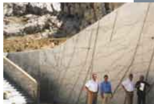
Obr. 4 Opěrná stěna divadla pod otevřeným nebem, výška 8 m, délka 50 m a tloušťka 250 mm, 90 m 3 Agilia® Vertical, 2000
