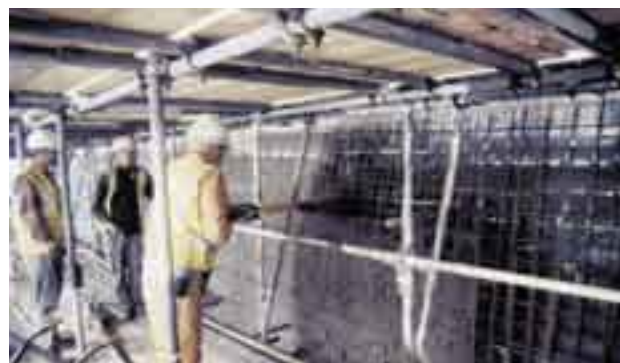
Obr. 3 Nástřik betonu
