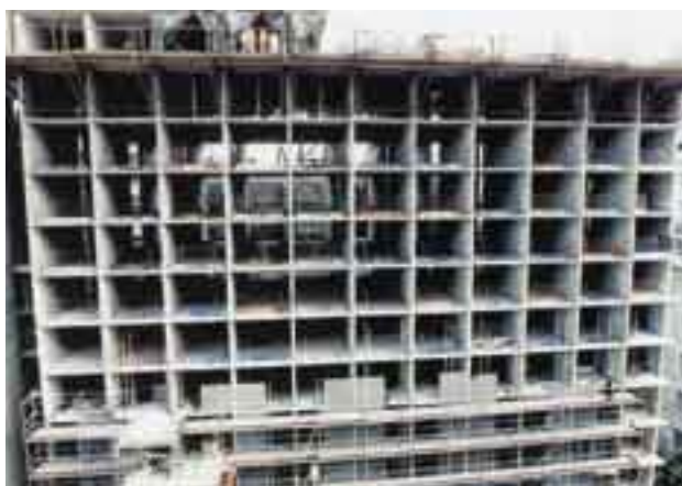
Obr. 8 Výstavba monolitické konstrukce
