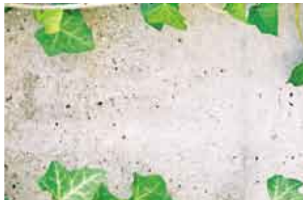
Obr. 1 Betonová stěna bytového domu v Baselu, Švýcarsko Fig. 1 Concrete wall of the house in Basel, Switzerland
