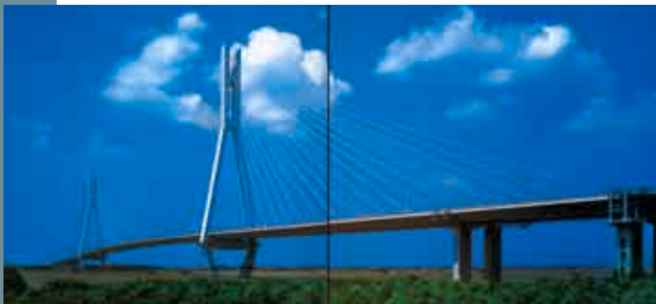
Obr. 2 Dokončený Druhý nankingský most
