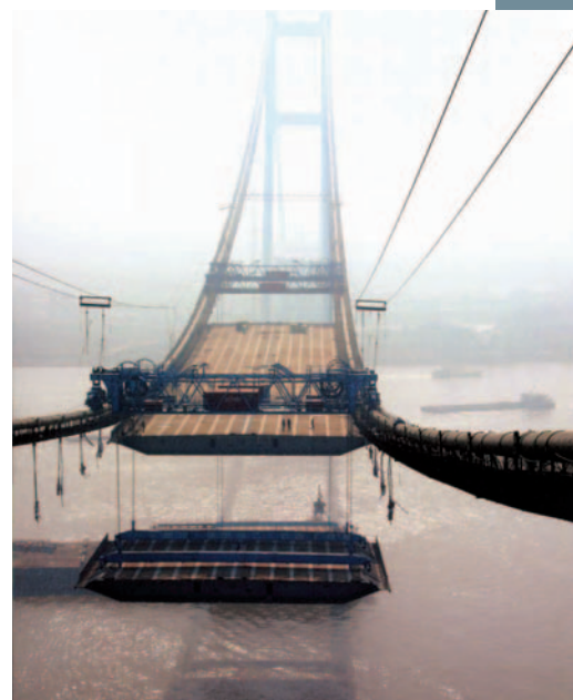
Obr. 11 Montáž mostovky visutého mostu Runyang
