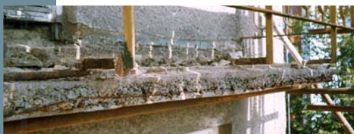
Obr. 5 Koroze výztuže balkonového nosníku Fig. 5 Corrosion of reinforcement of the balcony beam
