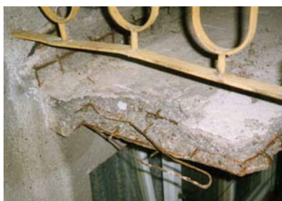
Obr. 5 Koroze výztuže balkonového nosníku Fig. 5 Corrosion of reinforcement of the balcony beam
