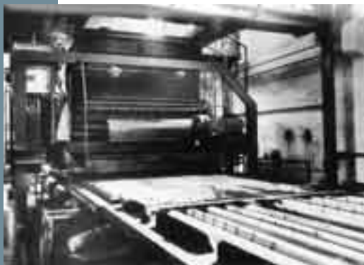
Obr. 8 Betonování panelu PPD Fig. 8 Panel PPD concreting
