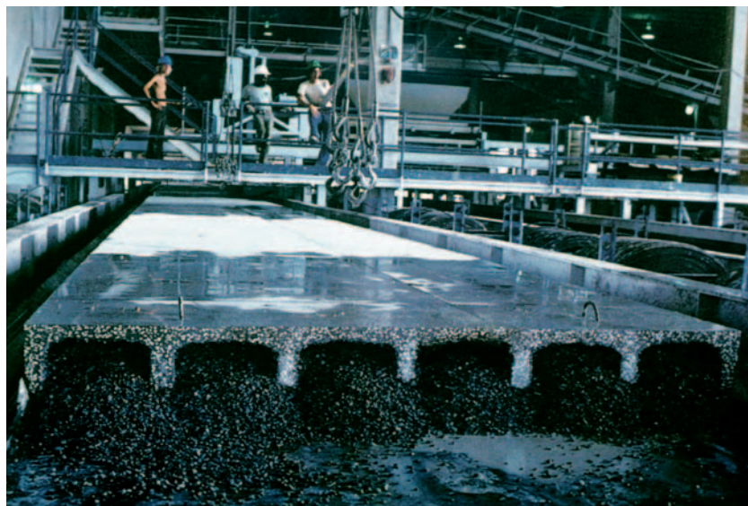
Obr. 10 Betonový pás po přeřiznutí Fig. 10 Concrete stripe after cutting
