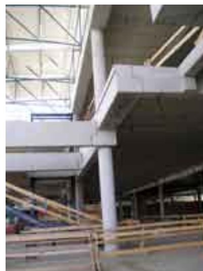
Obr. 18 Pohled na 44t nosník s převislými konzolami
