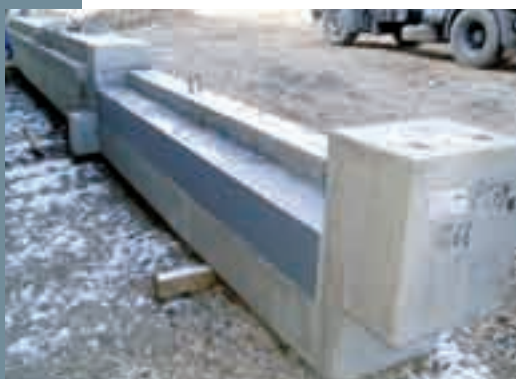
Obr. 9 Hlavní příčný nosník pro strop s travelátory
