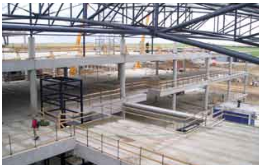
Obr. 17 Příletová hala Fig. 17 Arrival hall
