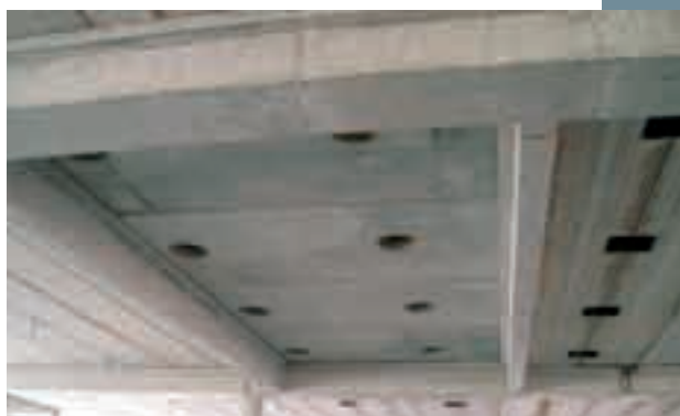
Obr. 5 Vytváření otvorů v stropních konstrukcích Fig. 5 Making holes in floor structures
