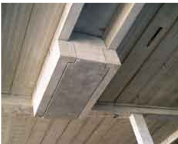
Obr. 13 Prefabrikovaný dojezd výtahu Fig. 13 Prefabricated truck zone
