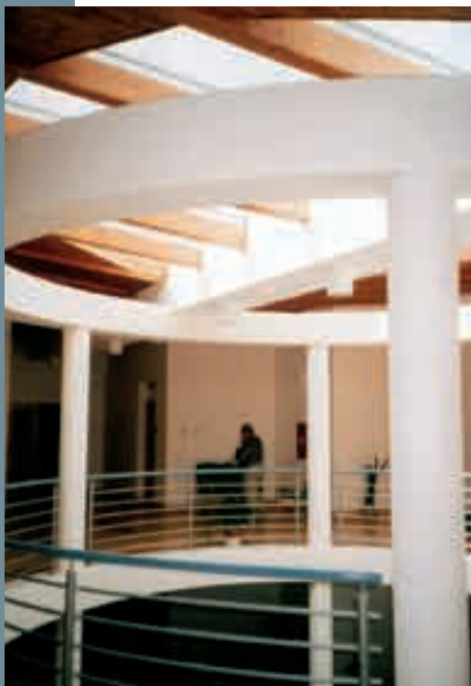
Obr. 9 Výsledný pohled do kruhového prostoru s průběžným prefabrikovaným žlabem Fig. 9 The resulting view of the circular space with a continuous prefabricated trough
