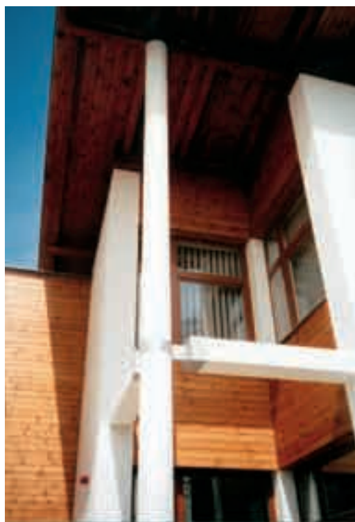
Obr. 10 Spojení průvlaků a sloupů na vstupním nároží Fig. 10 Joining of girders and columns on the entrance corner
