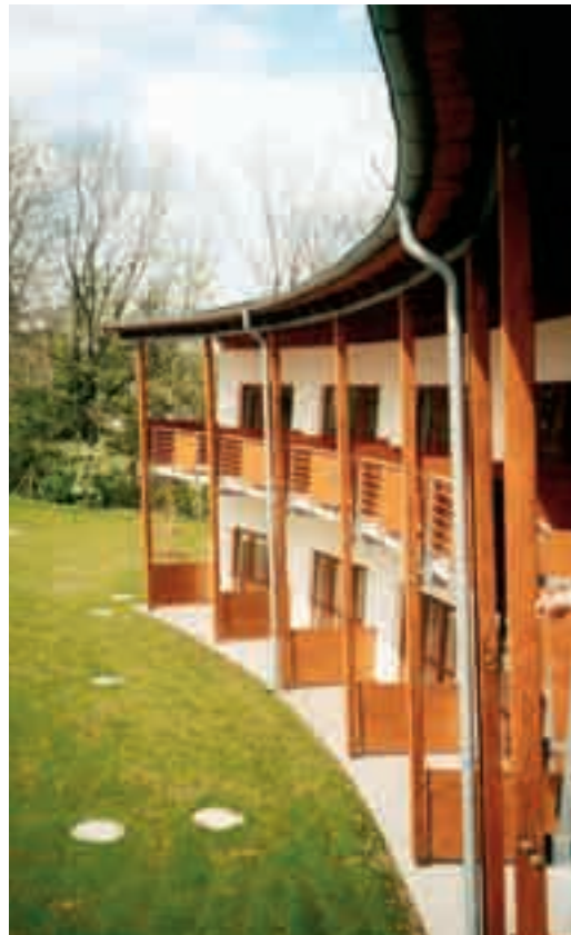
Obr. 4 Pohled na lodžie zakruženého prostoru ubytovací části „B“
