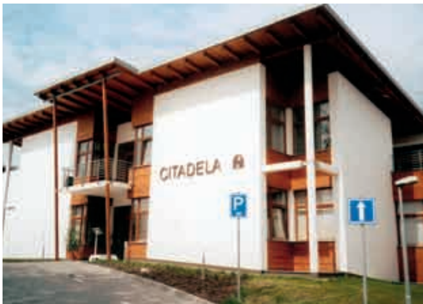
Obr. 1 Pohled na vstup centrální části „A“ hospice Citadela
