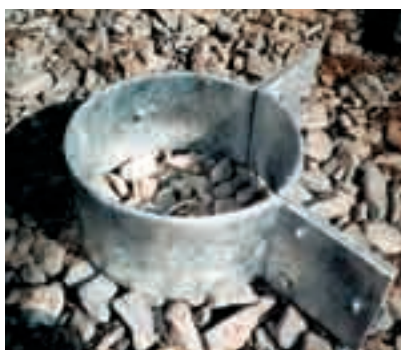
Obr. 11 Detail spojovací objímky sloupů a průvlaků
