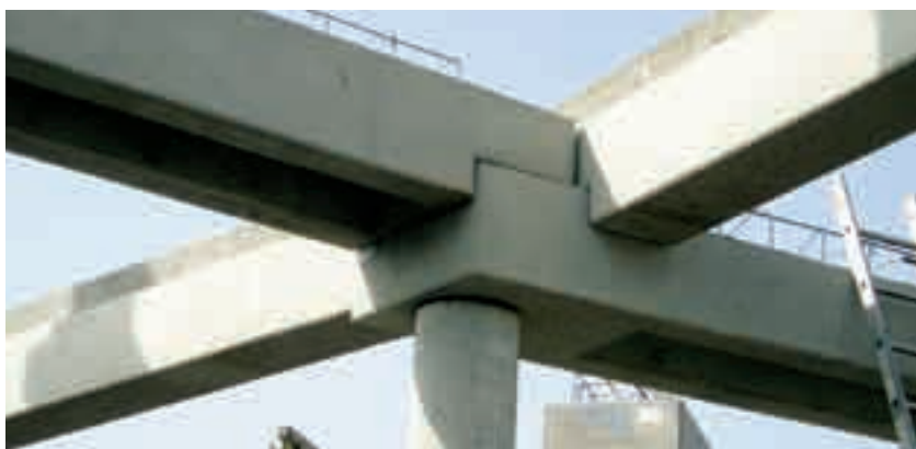
Obr. 13 Křížení čtyř nosníků nad kruhovým sloupem
