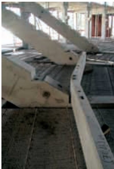
Obr. 10 Tribunový nosník se zářezy na uložení lavicových dílců a jeho průnik stropní konstrukcí
