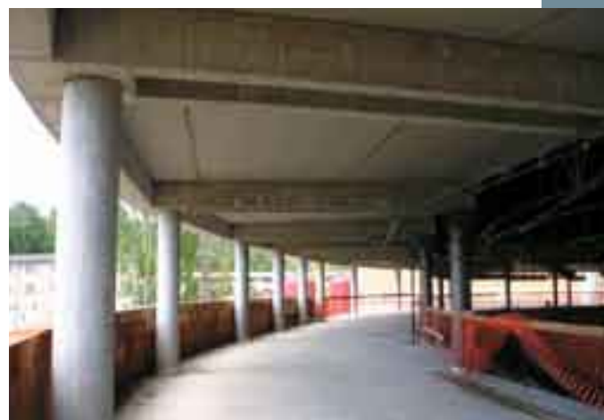
Obr. 6 Stropní konstrukce v zaoblené části
