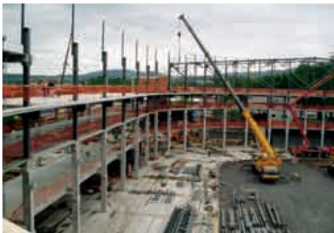
Obr. 16 Pohled na dodatečně upravenou konstrukci s vynecháním krajního pole třetího podlaží
