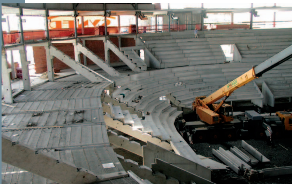
Obr. 9 Montáž prefabrikované tribuny z vnitřní již zastřešené plochy stadionu
