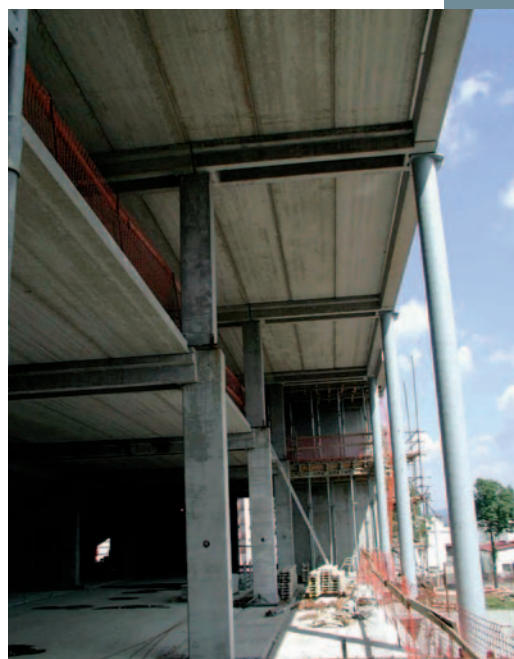
Obr. 16 Pohled na dodatečně upravenou konstrukci s vynecháním krajního pole třetího podlaží
