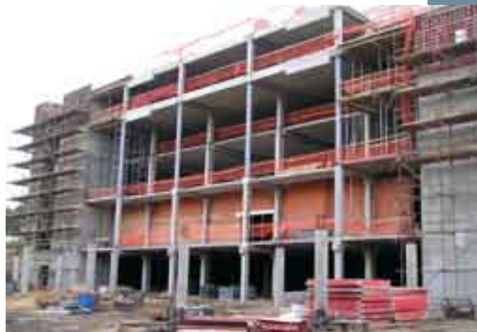
Obr. 16 Pohled na dodatečně upravenou konstrukci s vynecháním krajního pole třetího podlaží
