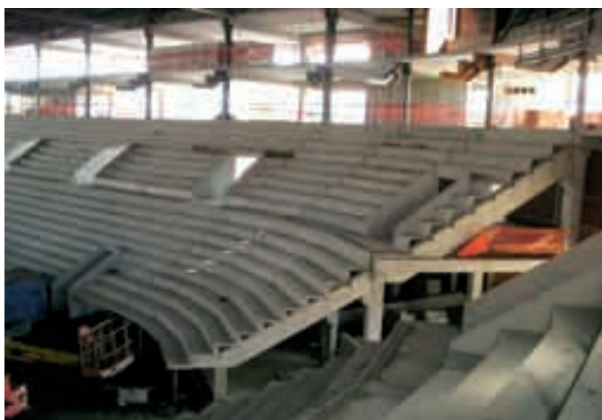
Obr. 4 Pohled na část obnaženého rámu s tribunovými nosníky a lavicemi
