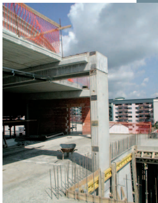
Obr. 14 Prefabrikovaný stěnový dílec – v předstihu montovaná podpora rámové přičle, je součástí monolitického komunikačního jádra
