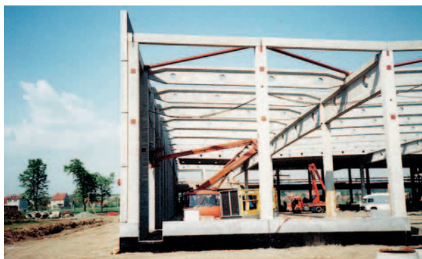
Tesco Prostějov – výstavba
