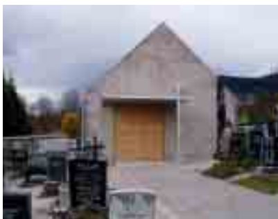
Obr. 1 Nová márnice z neomítaných vymývaných betonových tvárnic na hřbitůvku v Ramsau am Dachstein
