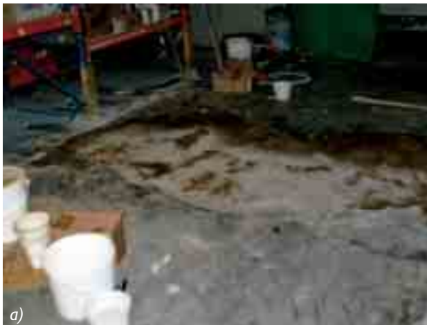
Obr. 5 a) přesypaná první vrstva vysprávký, b) vrchní vrstva přesypaná jemným pískem
