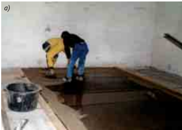
Obr. 2 a) plošná vyrovnávka podlahy skladu v tloušťce 50 mm, provedení vodítek a zahájení pokládky, b) napojení dalšího záběru k předchozímu zhuštěnému a uhlazenému pásu
