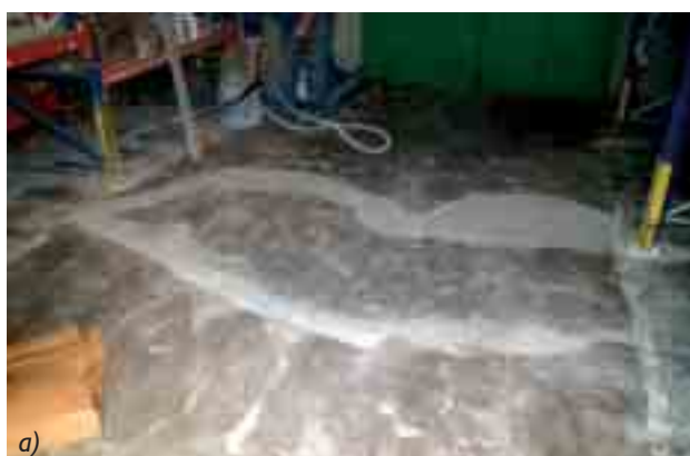
Obr. 4 a) vybroušený obvod opravovaného místa na minimální tloušťku vrstvy 3 mm, b) místo po nanesení penetrace
