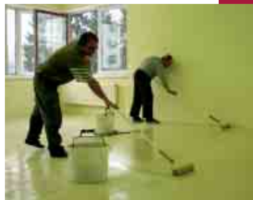
Obr. 6 Aplikace epoxidové podlahy v prostorách zdravotnického zařízení
