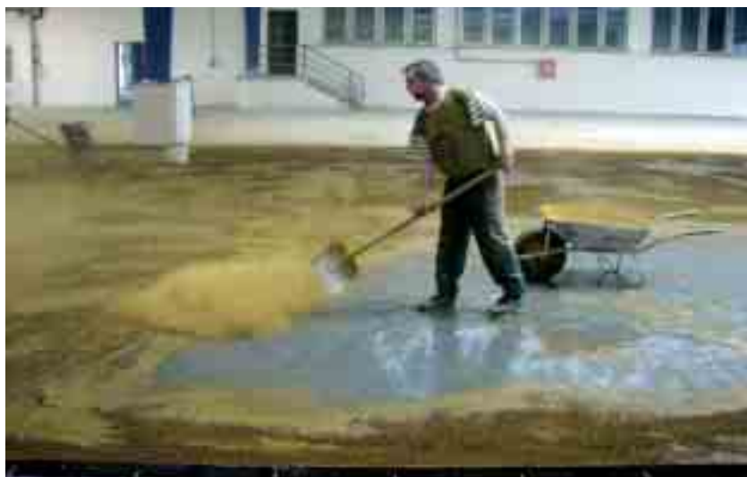
Obr. 3 Ruční aplikace vsypu na tuhnoucí betonové podlaze
