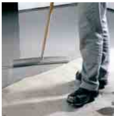
Obr. 13 Lití probarvené stěrky Fig. 13 Placing of coloured trowel-on coating
