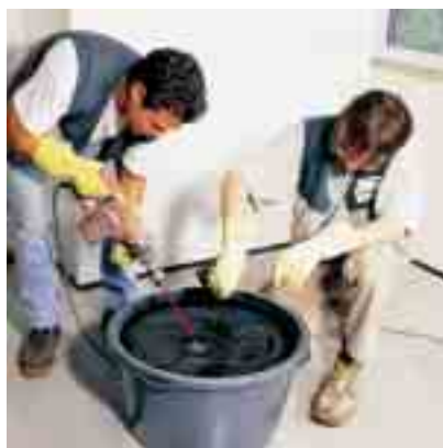
Obr. 12 Barvení záměsové vody Fig. 12 Mix water colouring
