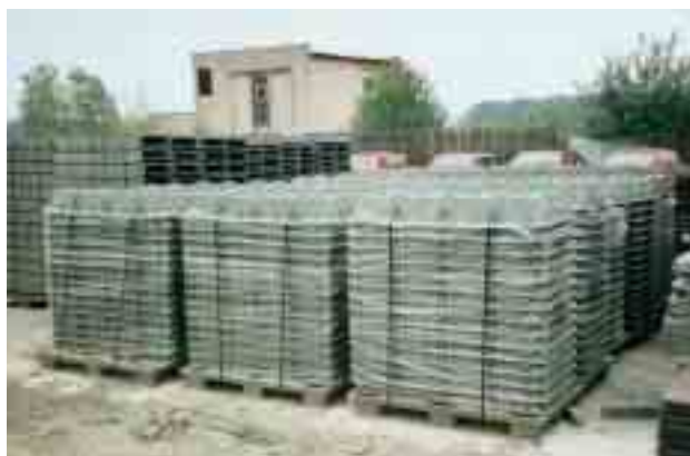
Obr. 2 Kazetové vložky na paletách připravené k distribuci, na jedné paletě jsou vložky pro 11 m 2 kazetového stropu Fig. 2 Waffle fillers prepared for distribution, one pallet contains fillers for 11 m 2 of waffle floor slab
