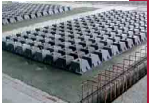
Obr. 5 Skladba pole vložek před uložením výztuže
