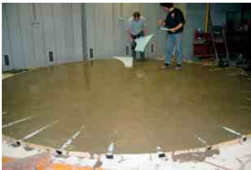
Obr. 4 Rovinná železobetónová platňa po ukončení betonáže
