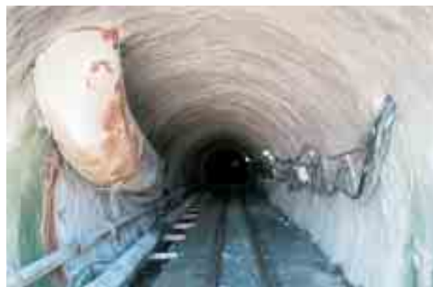
Obr. 2 Súprava na dopravu čerstvého betónu pri aplikácii sekundárneho ostenia
