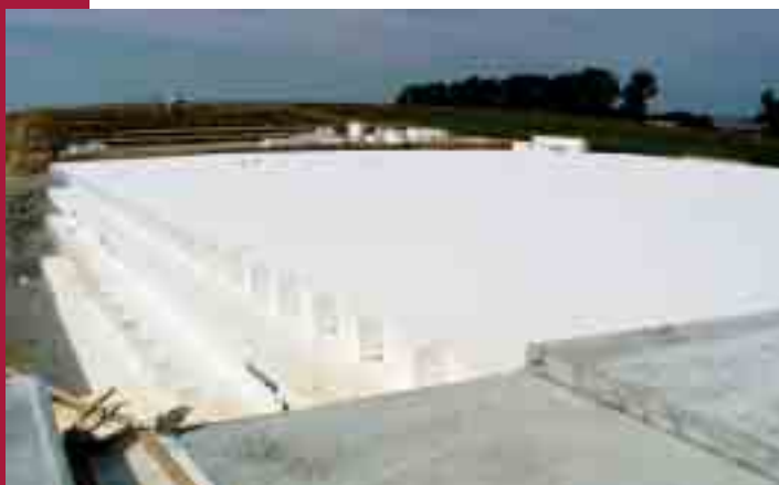
Obr. 14 Kladení polystyrenového násypu v ose mostu
