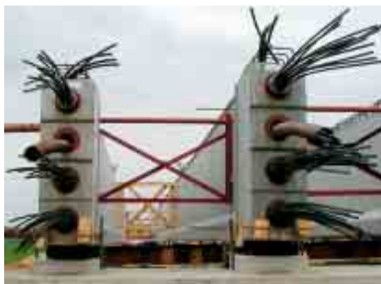
Obr. 10 Čela předpjatých nosníků po osazení do konstrukce mostu
