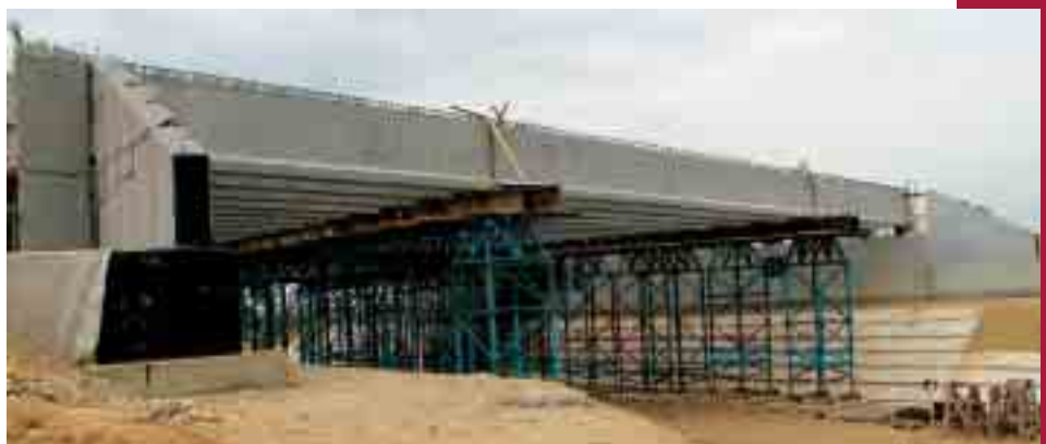
Obr. 13 Konstrukce mostu D211 – osazené předpjaté nosníky
