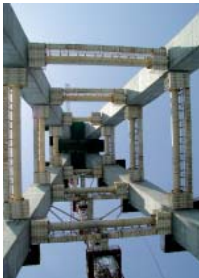
Obr. 2 Horní část pylonu M4 s provizorním rozezpěním Fig. 2 Upper part of the M4 pylon with temporary struts
