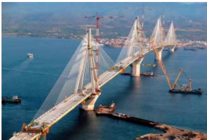
Obr. 5 Montáž předposledního segmentu 13.července 2004
