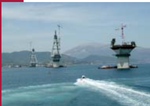
Obr. 2 Horní část pylonu M4 s provizorním rozezpěním Fig. 2 Upper part of the M4 pylon with temporary struts
