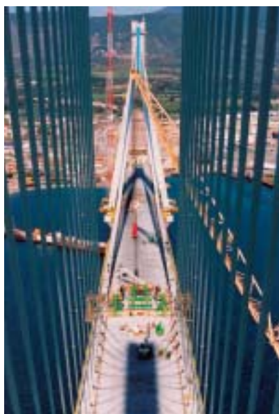
Obr. 4 Pohled z pylonu na dokončenou polovinu mostu
