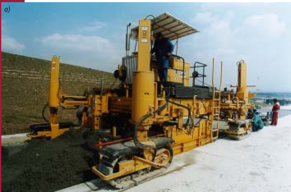
Obr. 1 Minifinišer CMI SF 2204 a) provádějící odstavný pruh dálnice, b) při betonáži žlabu Curb King
