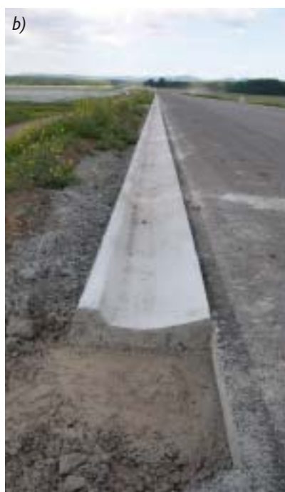
Obr. 2 Minifinišer HIT 1500 a) připravený na pokládku betonového žlabu Curb King, b) hotový žlab na stavbě obchvatu Uherského Hradiště
