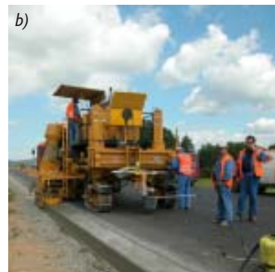
Obr. 1 Minifinišer CMI SF 2204 a) provádějící odstavný pruh dálnice, b) při betonáži žlabu Curb King
