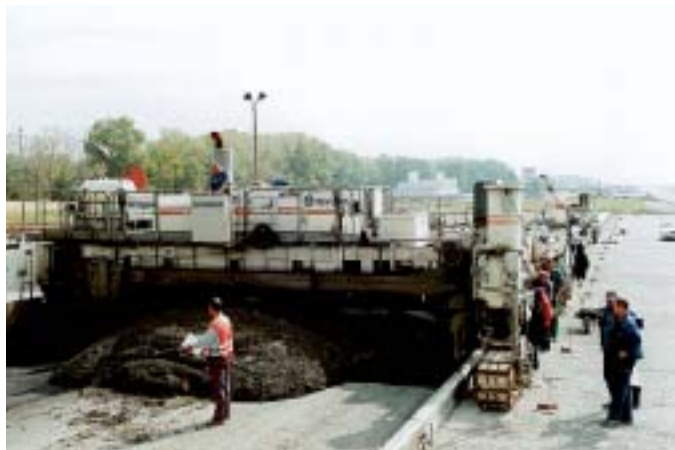
Obr. 2 Betonáž cementobetonového krytu do bednění na letišti Čáslav Fig. 2 Placement of the cement concrete cover in the formwork in the Čáslav airfield
